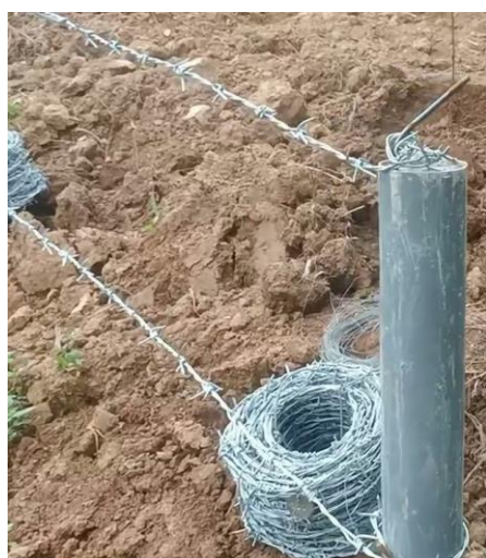
Hình 4.30: Làm hàng rào dây thép gai
