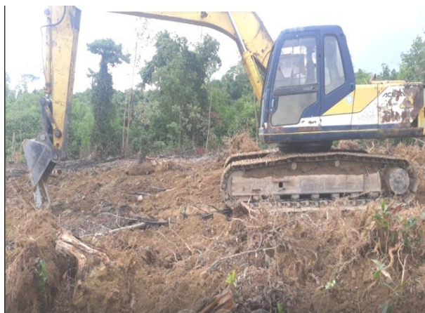
Hình 4.27: Nhổ bỏ gốc cây chu kỳ trước được thực hiện tại Công ty TNHH MTV Lâm nghiệp La Ngà (Ảnh do Công ty cung cấp)
